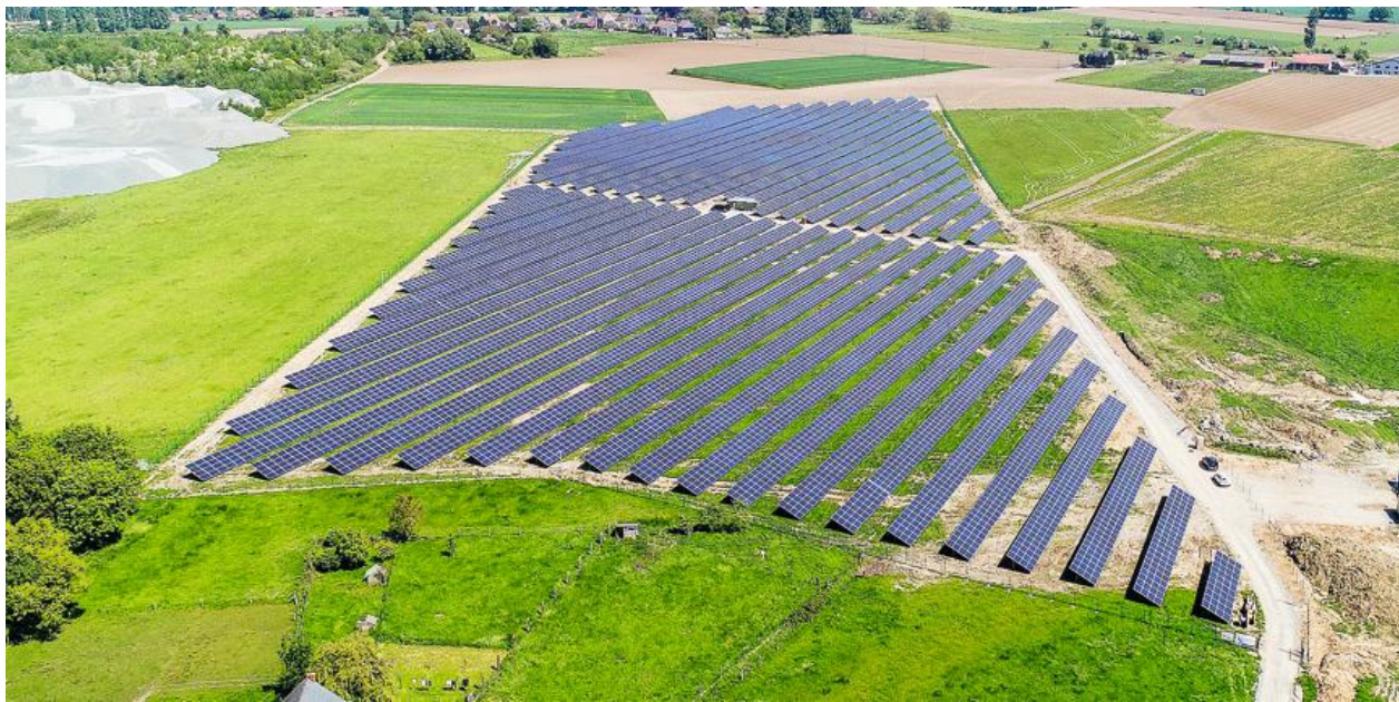
■ Il est prévu d'installer 37 000 panneaux photovoltaïques sur quelque 13 ha sur ce site à cheval sur la sablière d'Alconval. © DEHENEFFE
